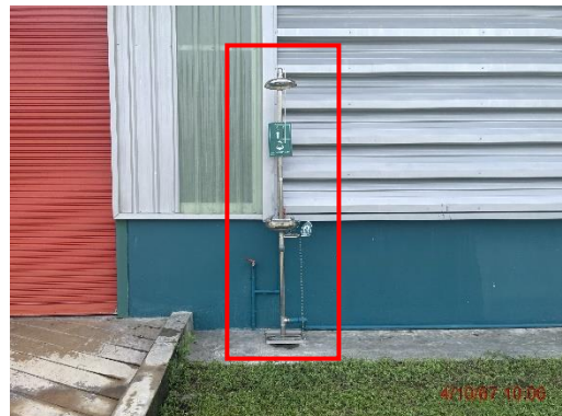
รูปที่ 41 ฝักบัวล้างตาฉุกเฉิน
