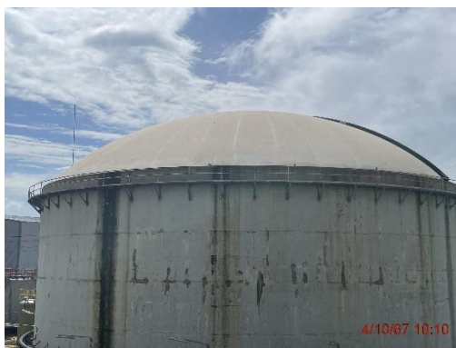
รูปที่ 4 การคลุมบ่อ UASB
