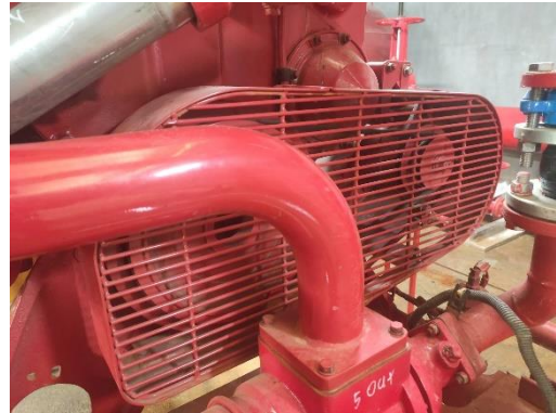
รูปที่ 53 การติดตั้งการป้องกันอันตราย
